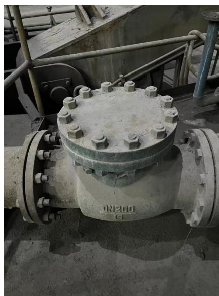
图 8 排气管止回阀
