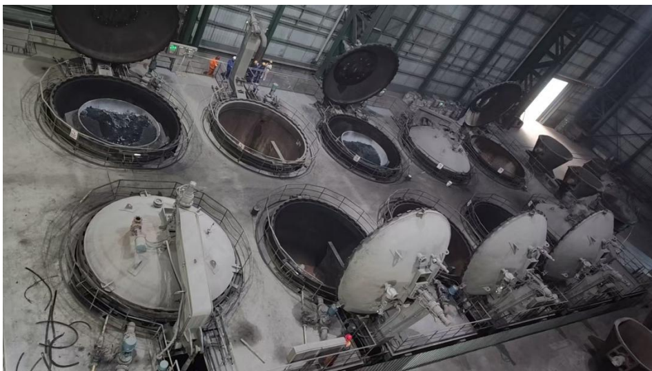
图 3 反应罐（热焖罐）区俯视图
