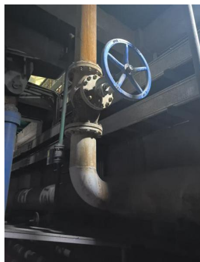
图 10 排气管截止阀
