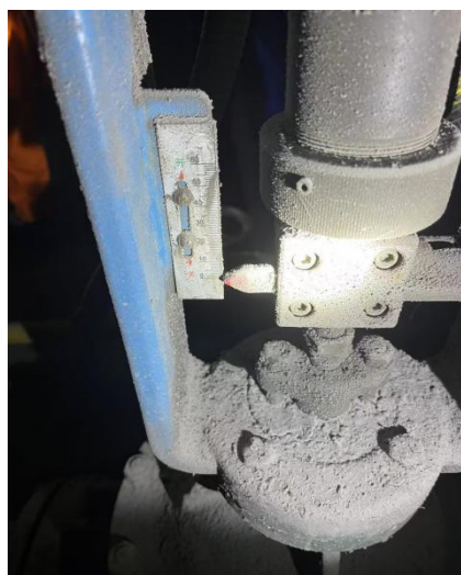
图 9 排气管电动调节阀
