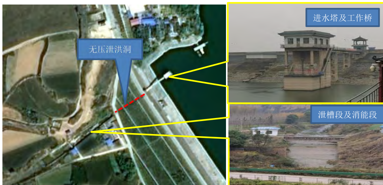
图 3.1-5 泄洪洞区域现状
