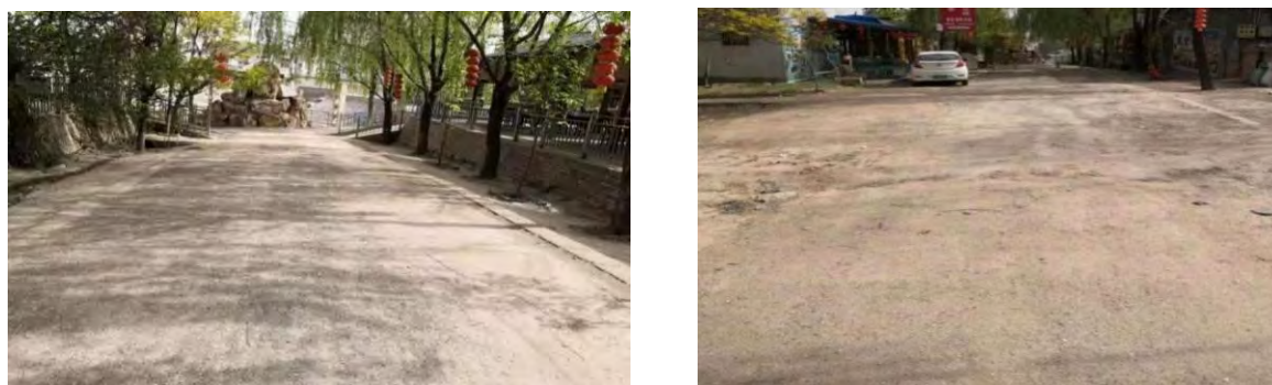
图 3.2-5 防汛抢险道路现状
