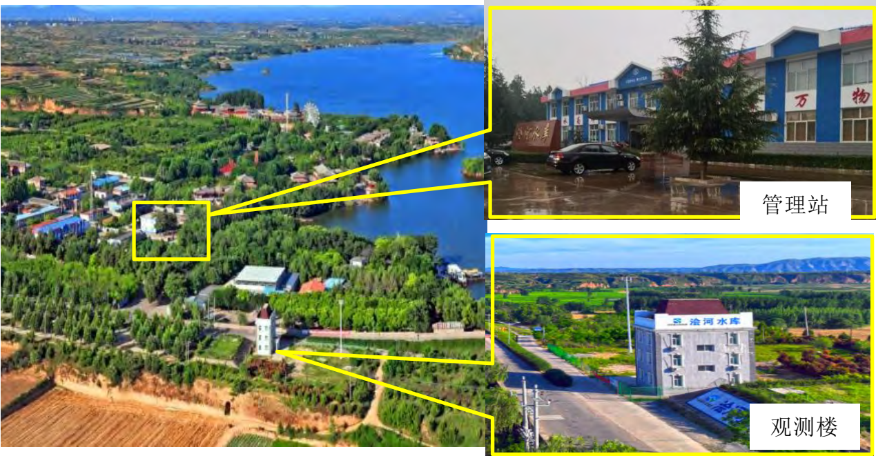
图 3.1-6（1） 管理站和观测中心现状
