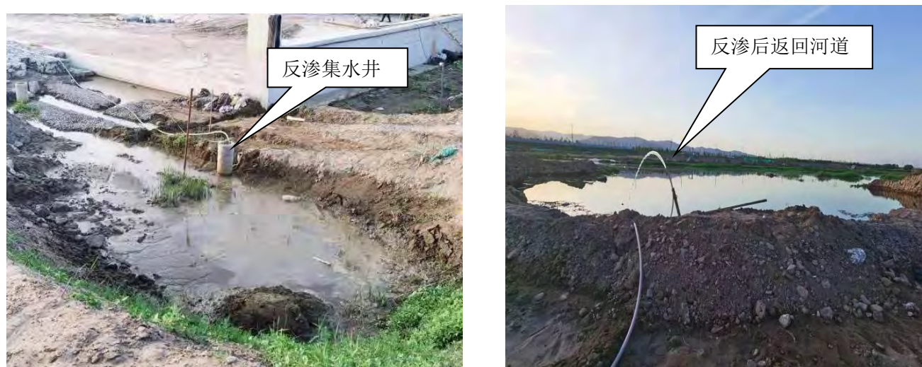
图 8.2-1 基坑废水处理示例图
