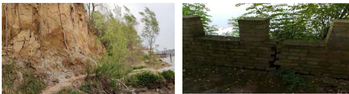
图 3.2-4 右岸高陡边坡现状
