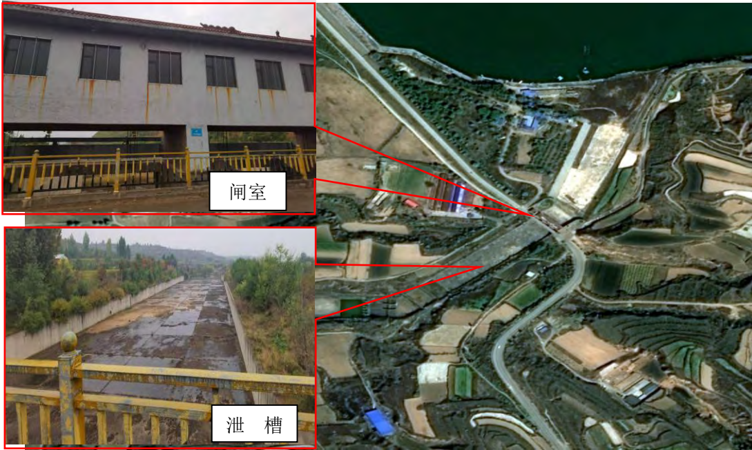
图 3.1-4 溢洪道区域现状
