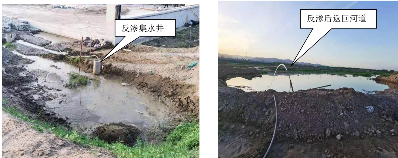
图 8.2-1 基坑废水处理示例图
